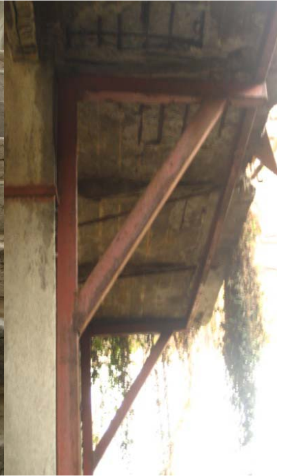
refuerzo de la losa
